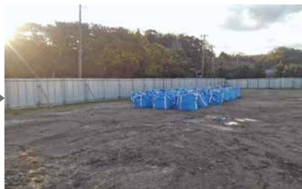
南房総市 (南房総市役所本庁舎東側駐車場仮置場 作業完了)
