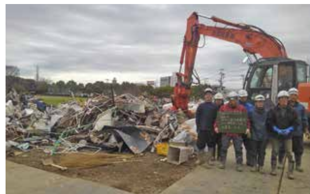
茂原市 (落合公園仮置場)
