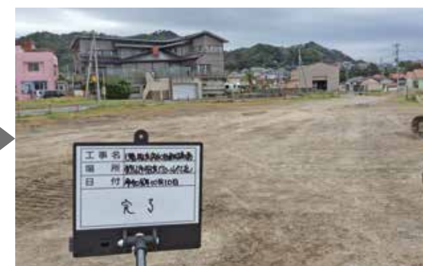
館山市 (相浜海水浴場駐車場集積場 作業完了)
