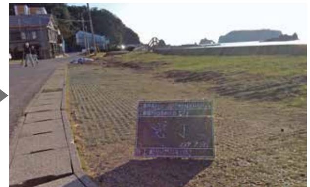
鋸南町 (竜島集積所 作業完了)
