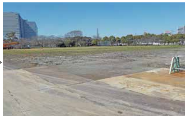
茂原市 (落合公園仮置場 作業完了)
