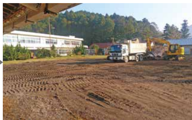
南房総市 (旧平群小学校グラウンド仮置場 作業完了)
