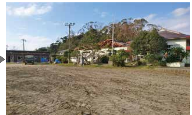
鋸南町 (旧佐久間小学校 作業完了)
