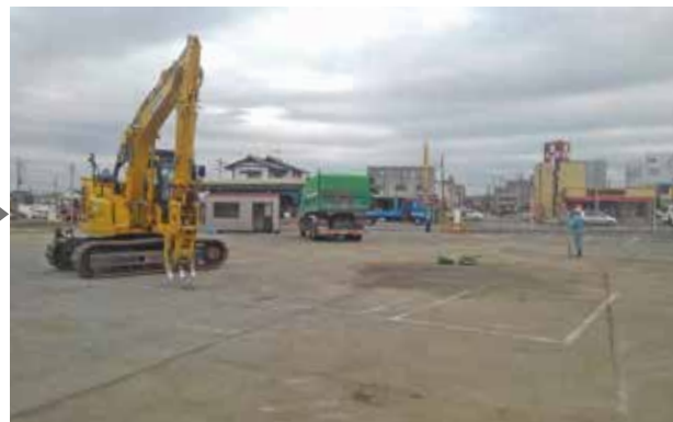
茂原市 (茂原公園第2駐車場仮置場 作業完了)
