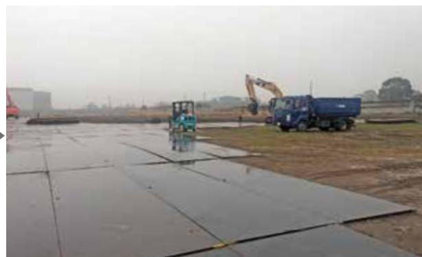
茂原市 (沢井製薬(株)所有地仮置場 作業完了)
