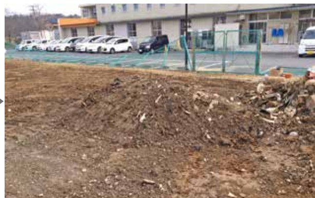
長柄町 (旧昭栄中学校跡地仮置場 作業完了)
