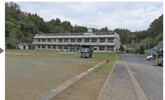
長南町 (旧豊栄小学校グラウンド仮置場 作業完了)
