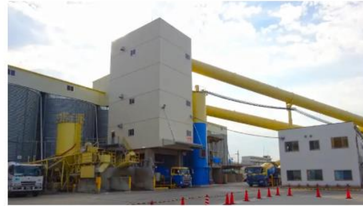
CO 2 を用いたコンクリート等製造技術開発 →
