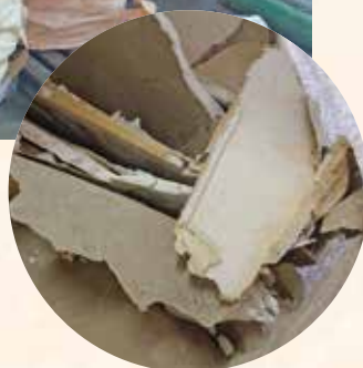
フレコン内の石膏ボード
